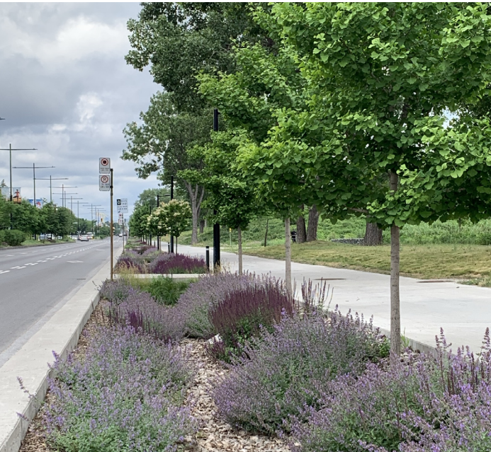
Exemple de noue drainante sur l'avenue Papineau EXP
