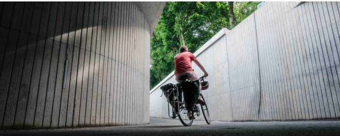
Exemple du tunnel cyclable de la Drève, Willeriken Werkenaan de ring
