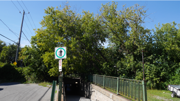
Tunnel piéton sous la voie du CN sur l’avenue Bourdages EXP
